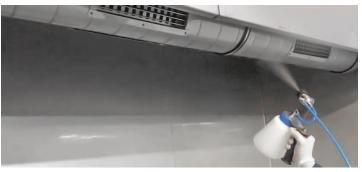
Lüftungsanlagen: Für die gezielte Desinfektion des Lufteinlasses finden Sie im Lieferumfang die Düse für die größere Wurfweite.
