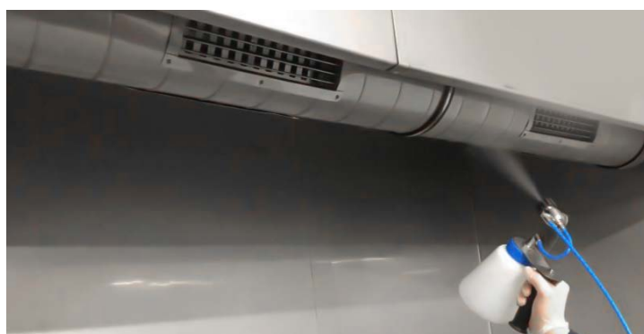
Lüftungsanlagen: Für die gezielte Desinfektion des Lufteinlasses finden Sie im Lieferumfang die Düse für die größere Wurfweite.
